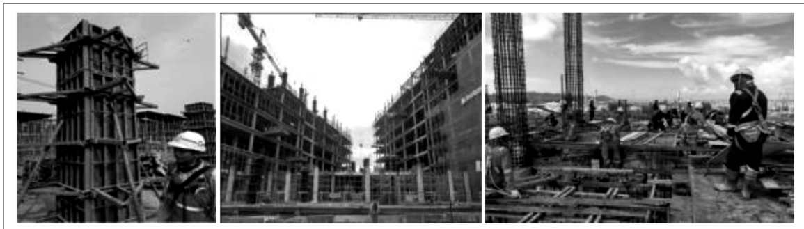
Gambar 5. Kegiatan Usaha Formwork
