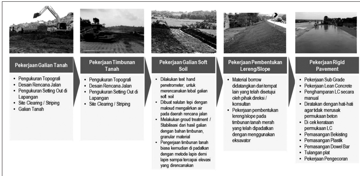
Gambar 10. Pelaksanaan Proyek Civil Works Jalan Tol
